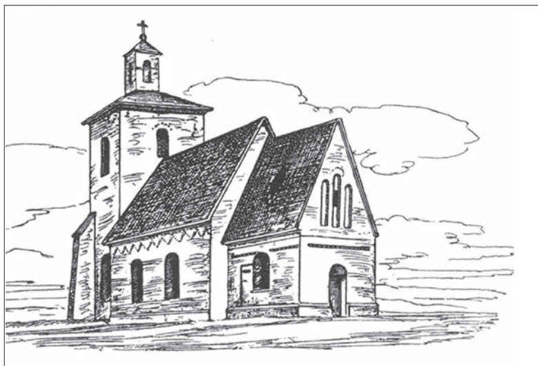
Figur 3. Ysby kyrka enligt en avbildning från 1858. Kyrkan har en dekorativ utsmyckning med trappstegsfris, strömskift samt en vällagd sockel. Korets gavelröste artikuleras med en trekopplad blinding (efter Brusewitz 1952).
